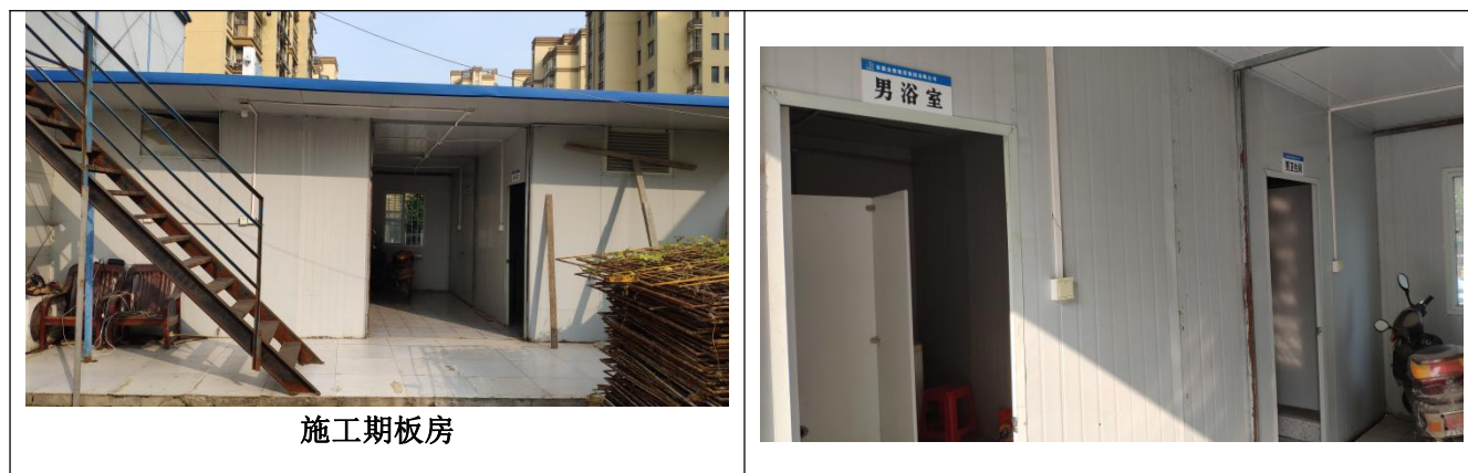
图 4.1-1 施工期环保设施照片
