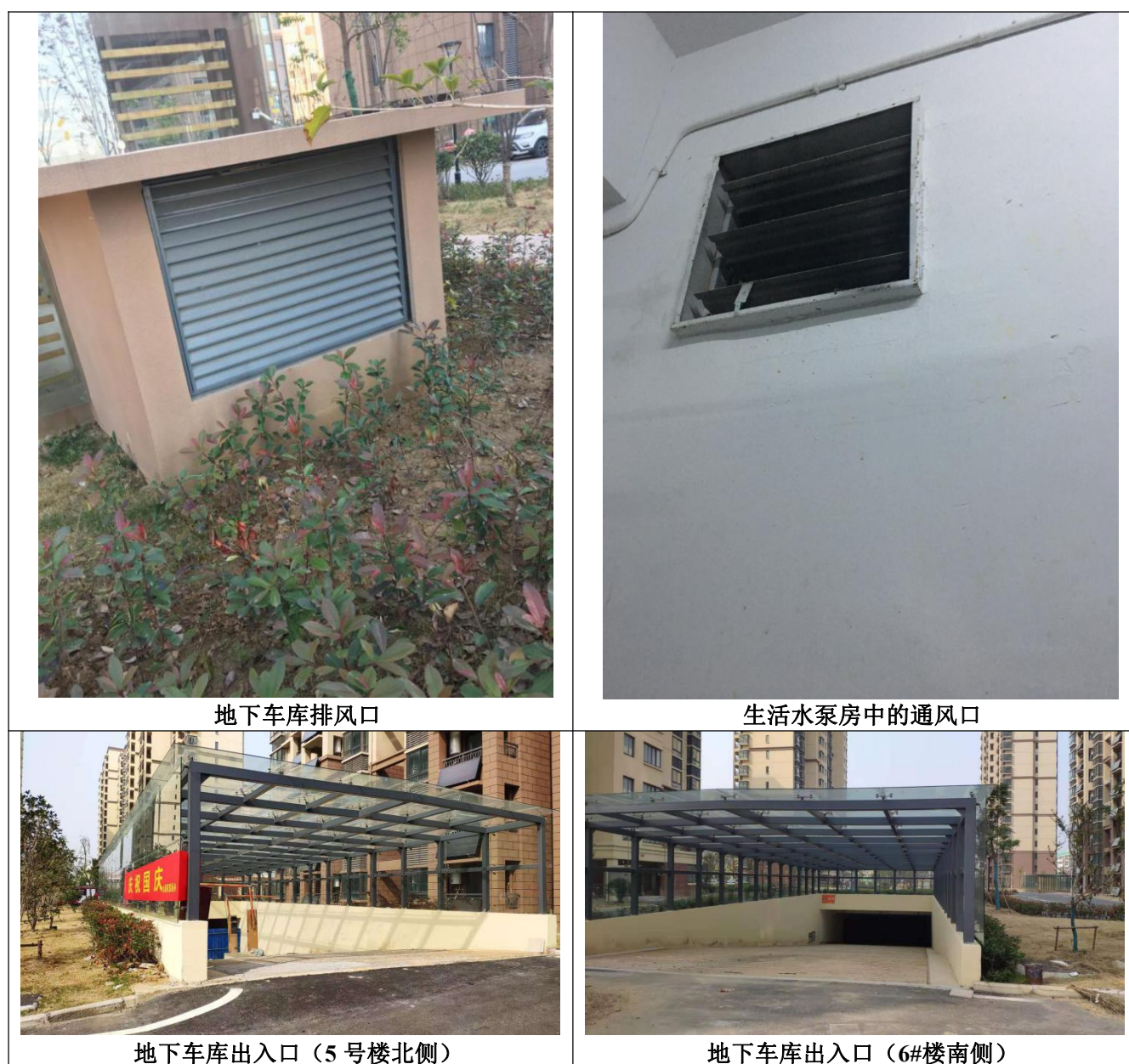
图 4.2-2 现场地下车库及排风口照片
