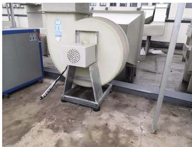
图 3-5 风机减震垫（2）
