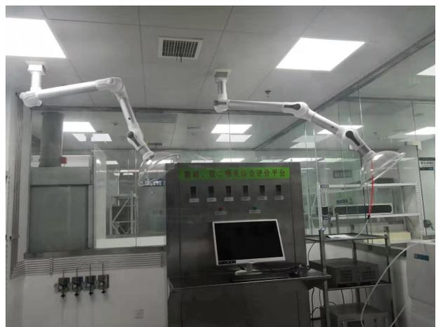
图3-4 三楼烟气脱硝检测实验室集气罩 (4)
