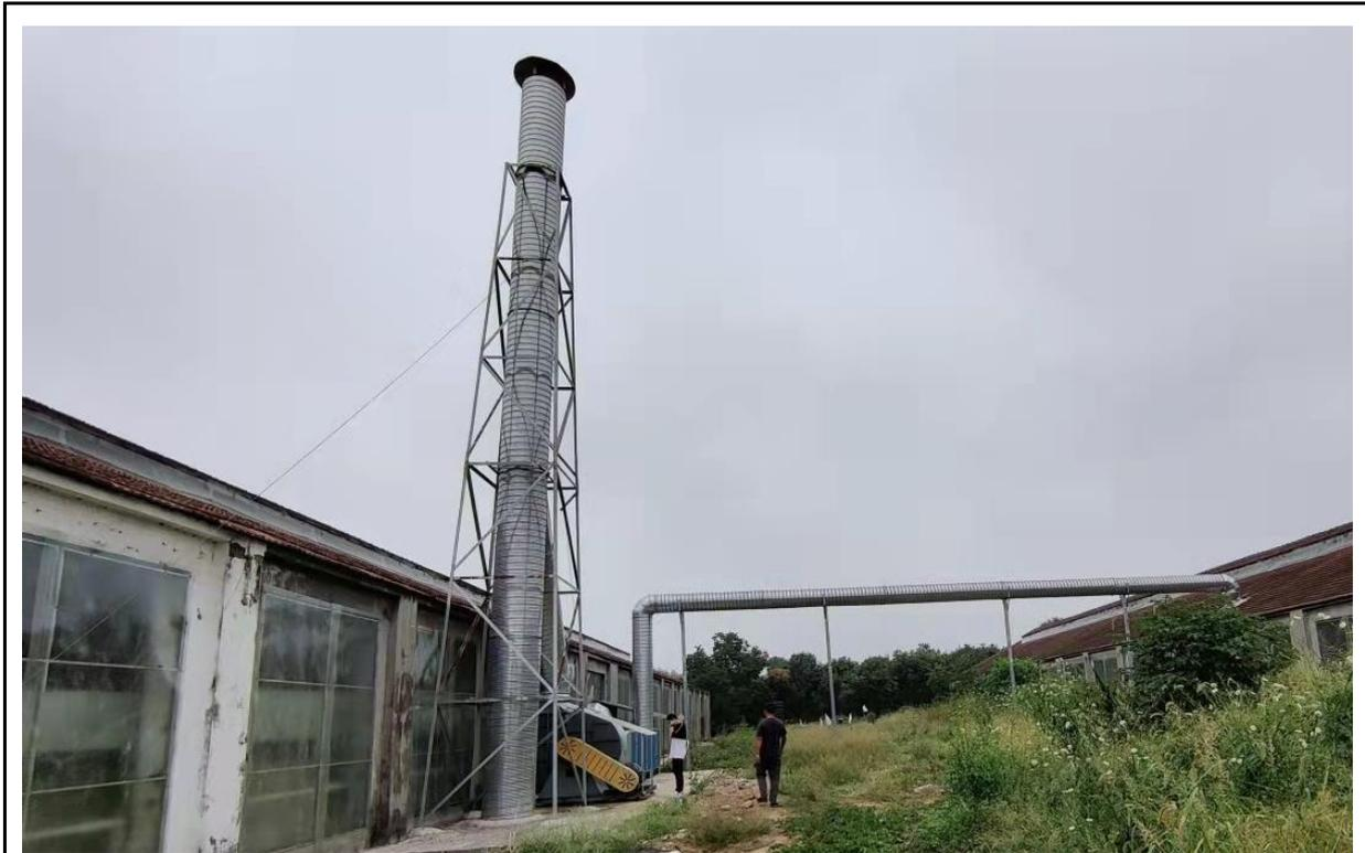
图 3-1 发酵车间废气处理设施
