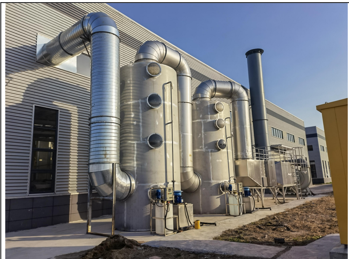
图 3-2 涂覆烘干废气处理设施
