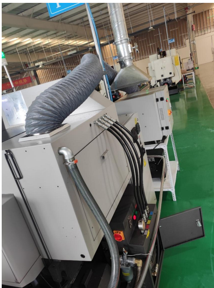
图 3-1 油雾废气收集措施
