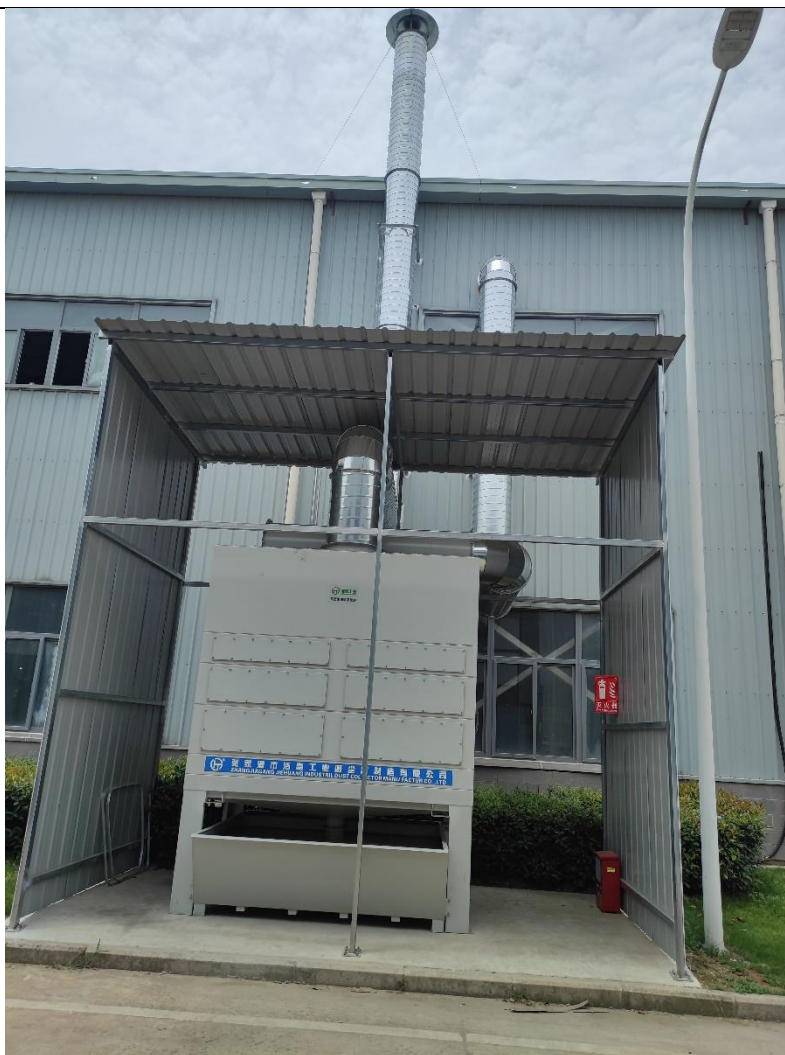
图 3-2 油雾废气收集、处理措施
