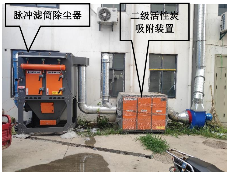
脉冲滤筒除尘器+二级活性炭吸附装置+20m 高排气筒
