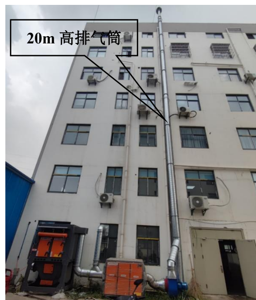
脉冲滤筒除尘器+二级活性炭吸附装置+20m 高排气筒
