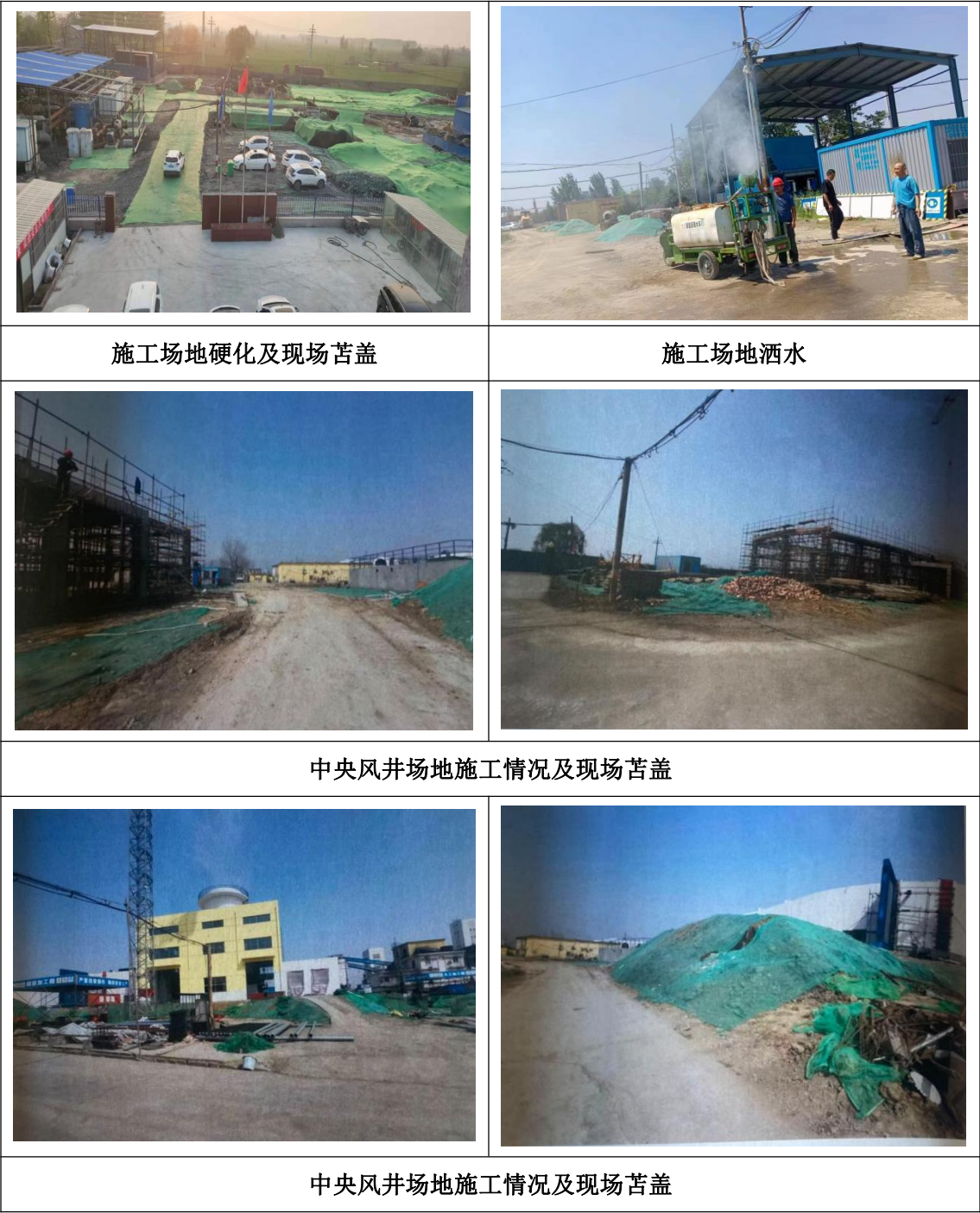
图 6.1-1 项目施工现场照片
