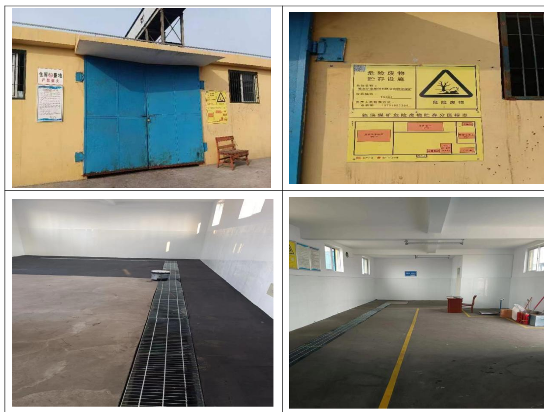
图 7.2-7 临涣煤矿现有危废库现场照片
