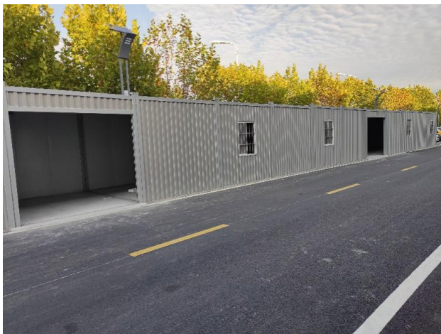
一般固废暂存间
