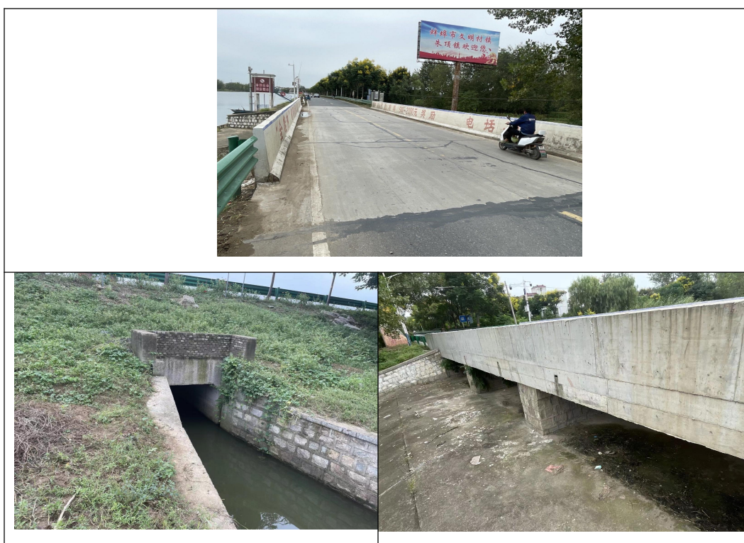
图 4-5 项目桥梁已建成现状图
