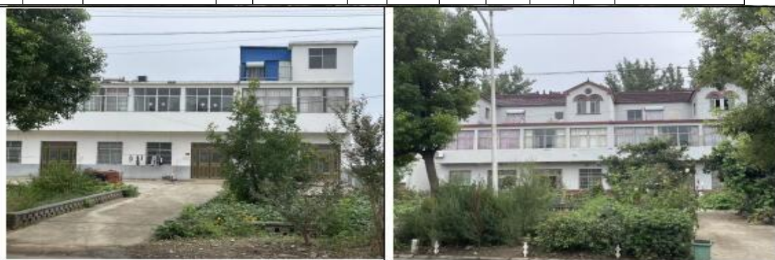
朱顶村整体及部分具体敏感点现场图
