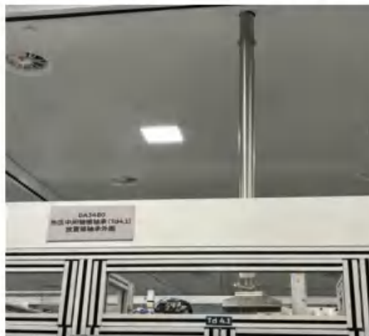
压装主壳体中间轴锥轴承外圈工序（热压中间锥轴承放置锥轴承外圈）集气罩布设情况
