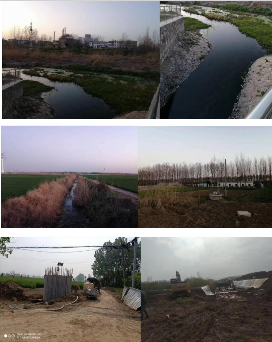
图7-1 施工期现场照片
