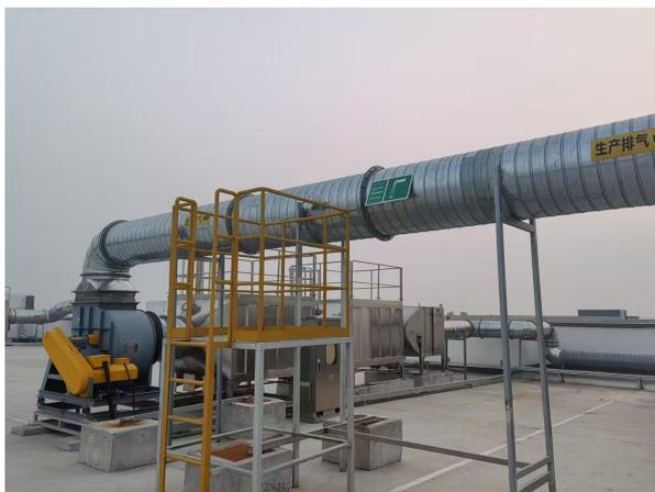
汽车电子钢网清洗废气由设备集气管收集，回流焊废气、补焊废气、选择焊废气、涂覆废气、组装废气和返修废气采取生产线全密闭负压收集，经1套干式过滤+二级活性炭吸附装置+25m高排气筒(DA003)
