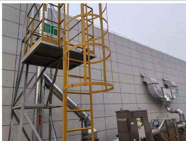
危废暂存间有机废气负压收集，经1套二级活性炭吸附装置+15米高排气筒（DA008）
