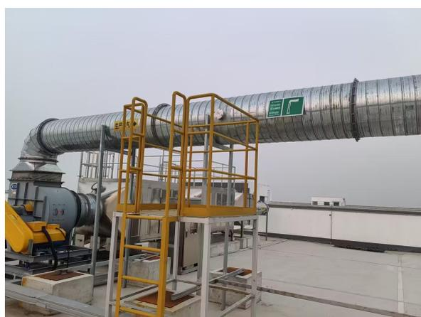
中低音扬声器粘接废气和焊接废气，采取生产线全密闭负压收集，经1套干式过滤+二级活性炭吸附装置+25m高排气筒（DA005）
