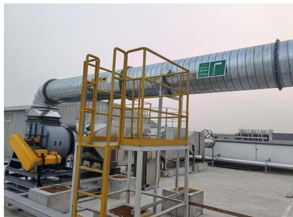
中低音扬声器粘接废气和焊接废气，采取生产线全密闭负压收集，经1套干式过滤+二级活性炭吸附装置+25m高排气筒（DA006）
