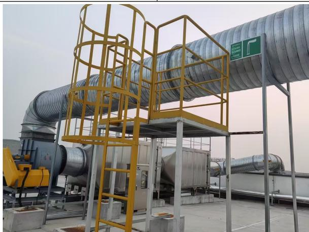
注塑废气、低音炮热板焊接废气经集气罩收集后+二级活性炭吸附装置+25m 高排气筒（DA002）
