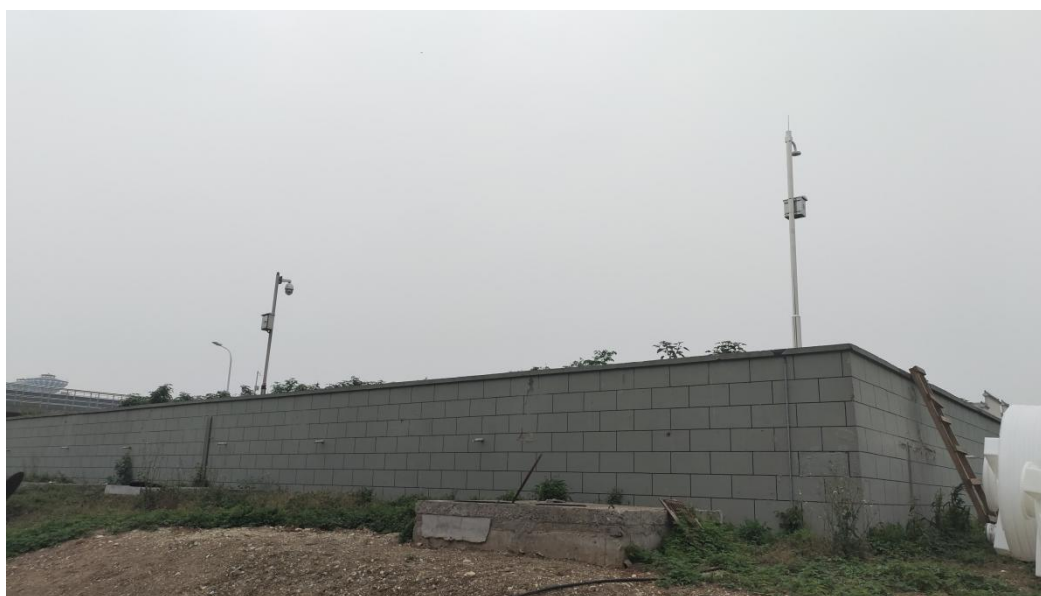
图 2-5 凤阳宁国现代产业园净水厂现状清水池
