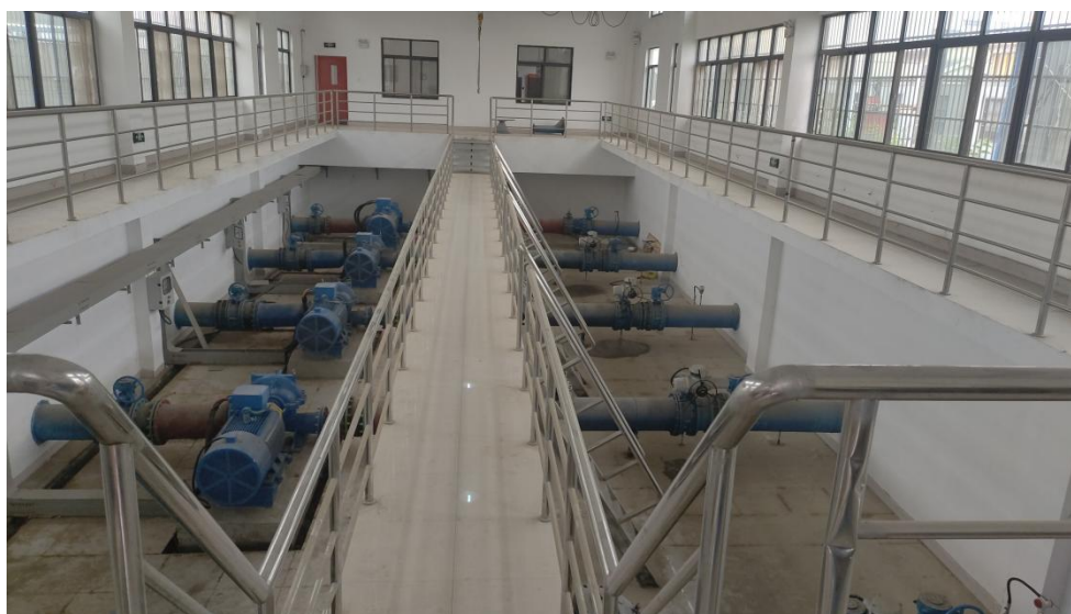
图 2-6 凤阳宁国现代产业园净水厂现状送水泵房
