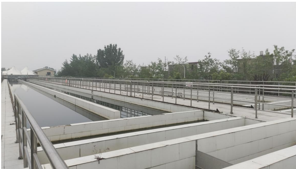
图 2-9 经开区净水厂现状折板絮凝平流沉淀池
