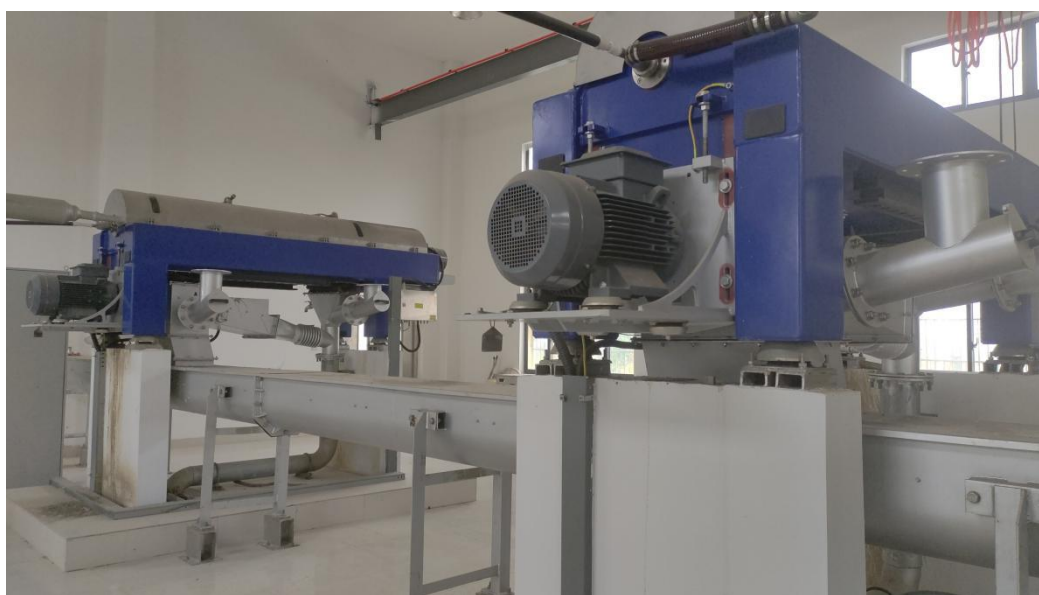
图 2-14 经开区净水厂现状污泥脱水机房
