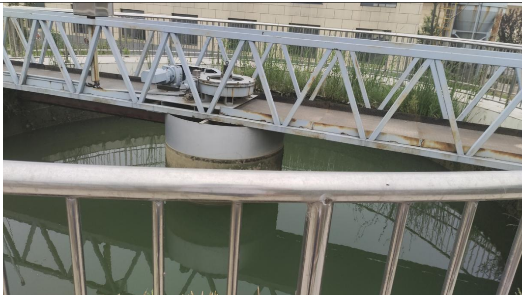
图 2-13 经开区净水厂现状污泥浓缩池
