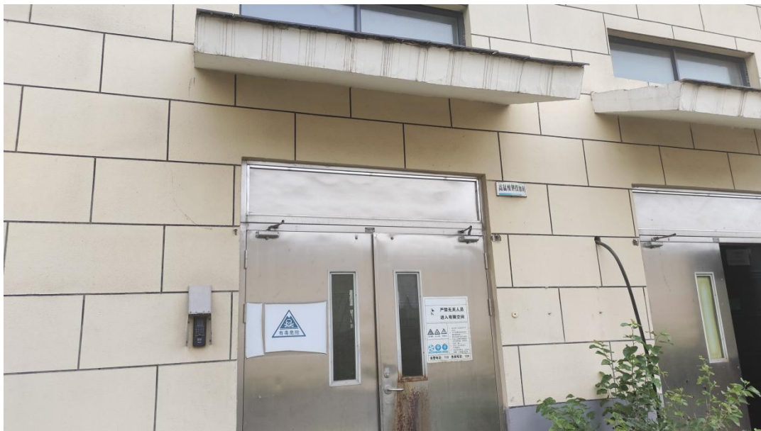
图 2-16 经开区净水厂现状活性炭及高锰酸钾投加间
