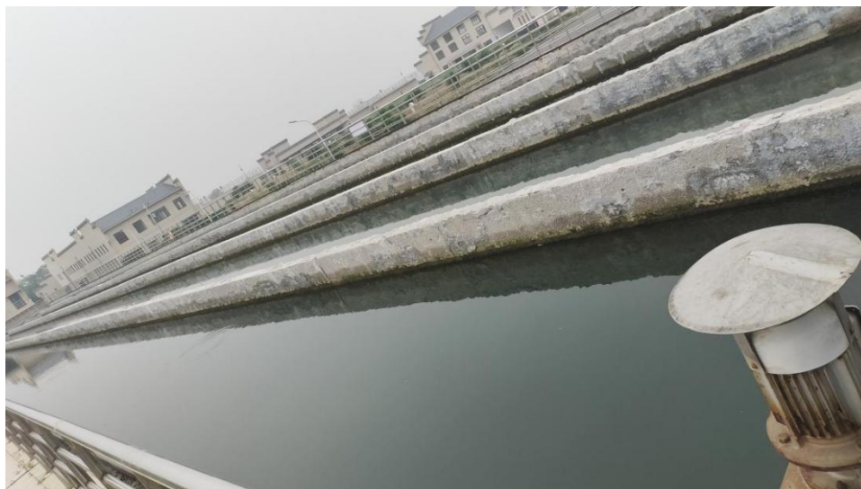
图 2-4 凤阳宁国现代产业园净水厂现状折板絮凝平流沉淀池
