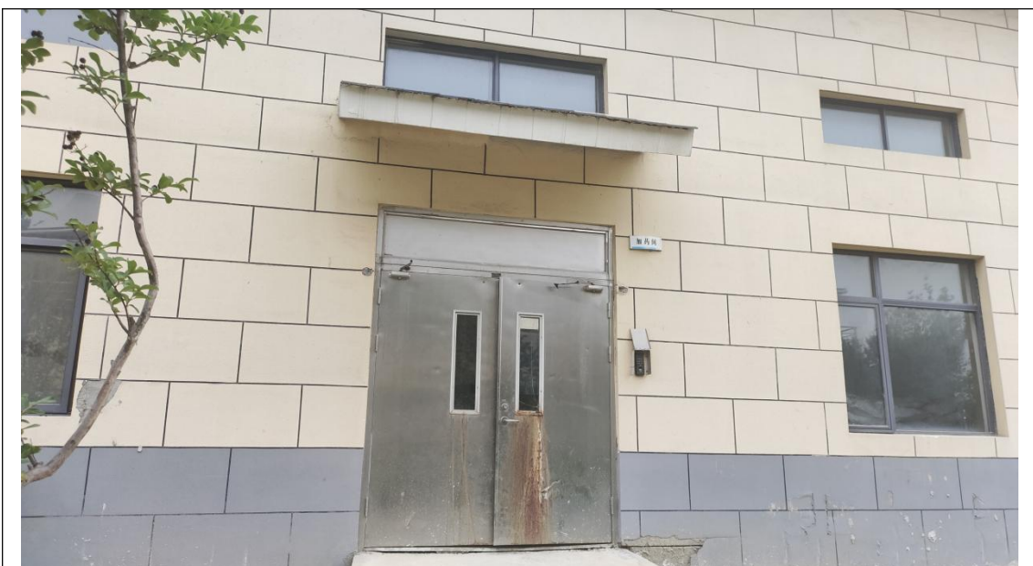
图 2-12 经开区净水厂现状综合加药间
